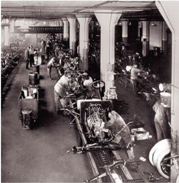
分業、フォード自動車工場における生産ラインの流れ作業（戦前）
