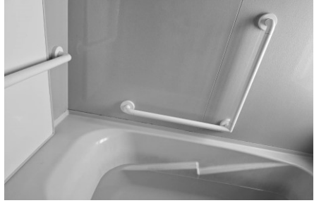
風呂の手すり設置
