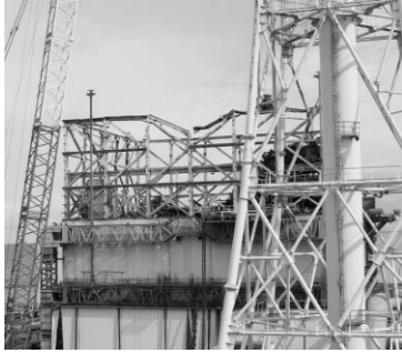
遅々として進まぬ廃炉作業 福島第一原発
