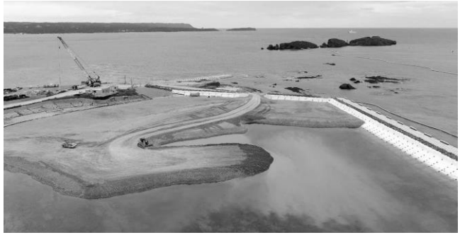
辺野古新基地建設埋め立て現場
