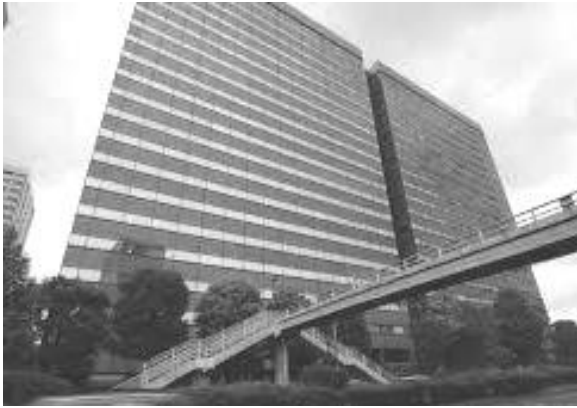
「検察庁法改正」で問題となった東京高等検察庁の前黒川検事長が在籍した東京高検が入る庁舎。
